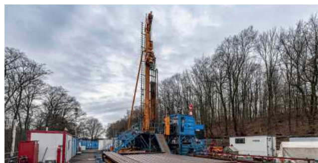
▲ Erkundung des Ansatzpunktes für den Rückholschacht Asse 5
