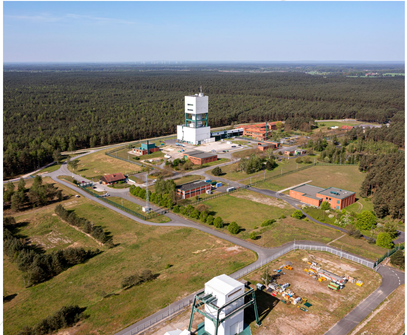
Das Bergwerk Gorleben und alle dazugehörigen Bauten über Tage stellen natürlich einen Eingriff in die Natur dar. Daher werden Ausgleichs- Ersatzmaßnahmen durchgeführt.
