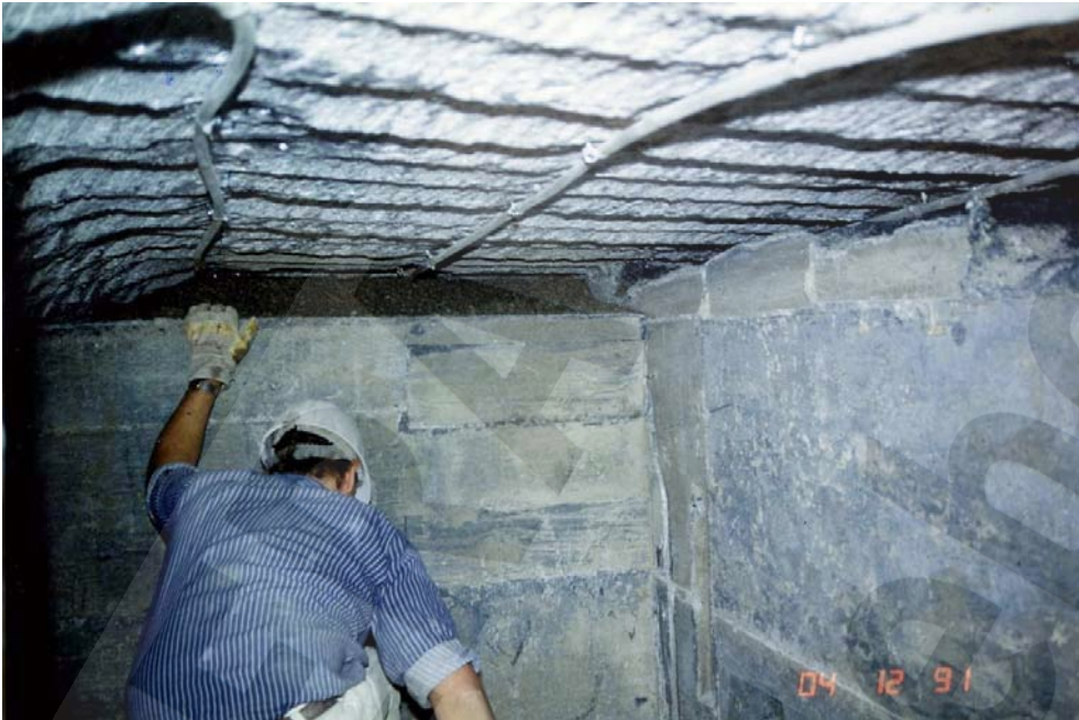
Abb. 55: ASSE-Vordamm mit Betonierabschnitten, teilweise verfüllter Firstspalt und Injektionsleitungen
