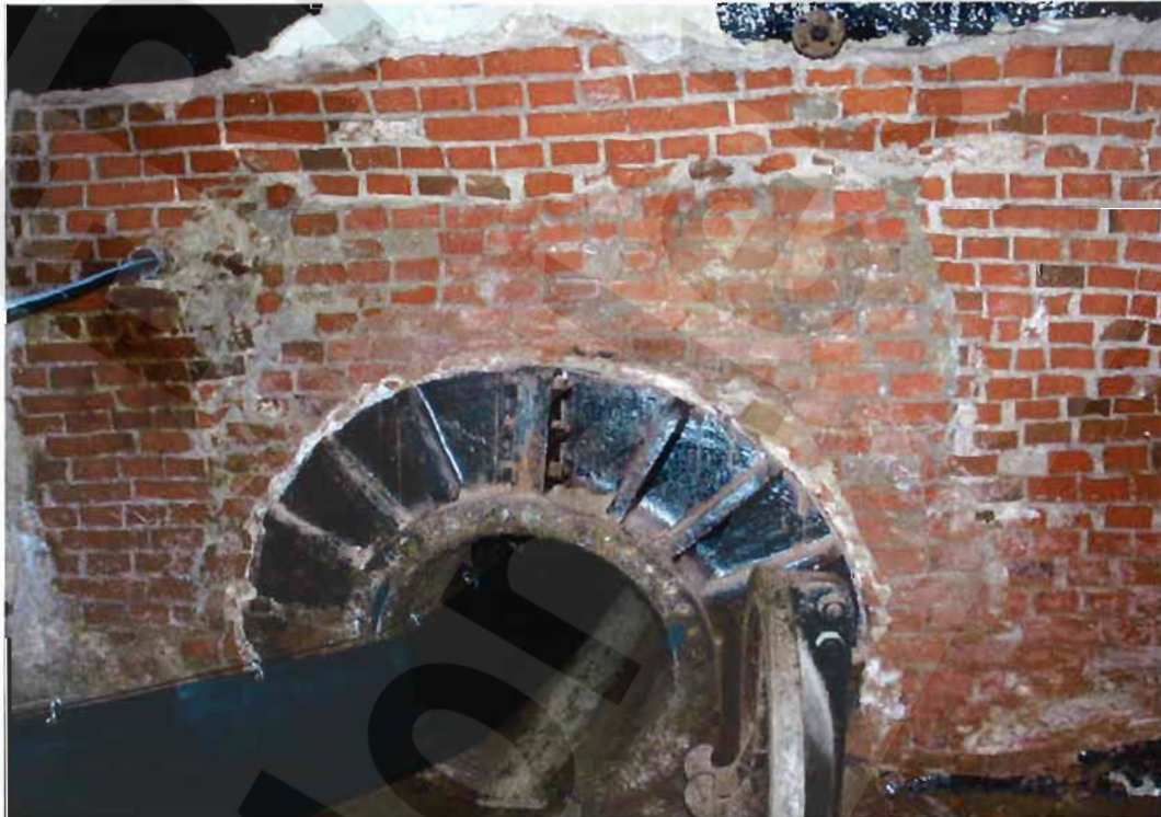
Bild 2: Ostseite des Dammtors Lager H (02AHB/HY001) im 2. Nordquerschlag der -231 mNN Sohle
