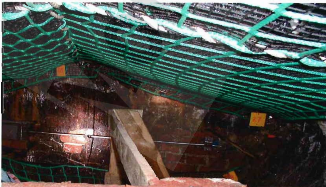
Bild 3: Stirnfläche Gewölbesegment 11 bei -188 mNN mit den Messstrecken CG007K und CG008E mit Messuhr. Stand: 26.02.03
