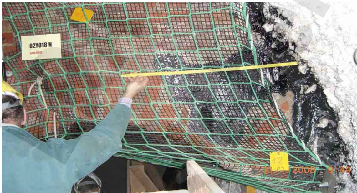
Abbildung 2: Stirnfläche des Gewölbesegementes GS 20, westlicher Bereich.
