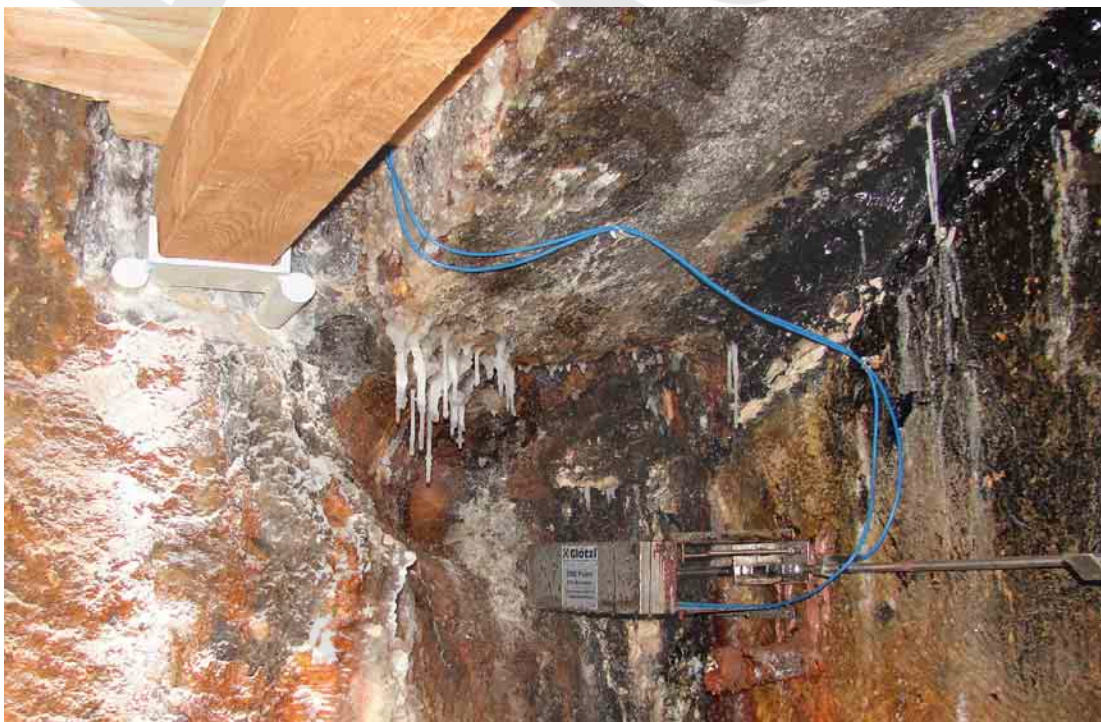
Abbildung 8: Gewölbesegment GS 4, Feuchtestellen am östlichen Stoß, Extensometerkopf CG011E
