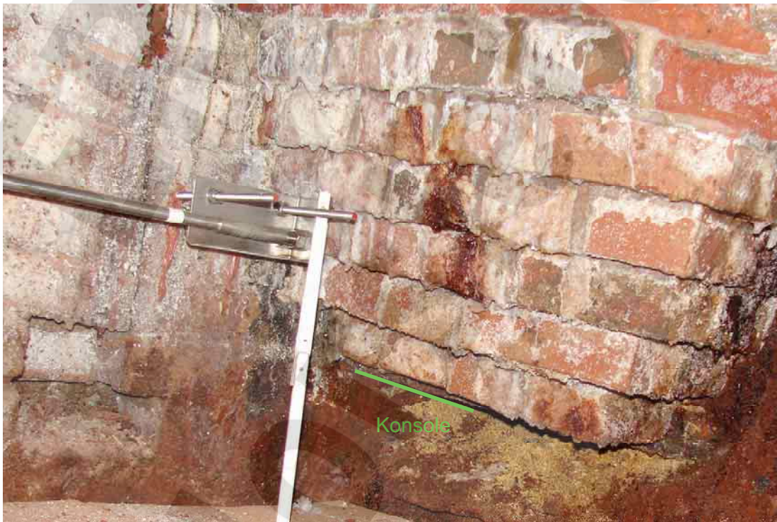
Abbildung 6: Gewölbesegment GS 5 bei -194 mNN, Mauerfuß am westlichen Stoß.
