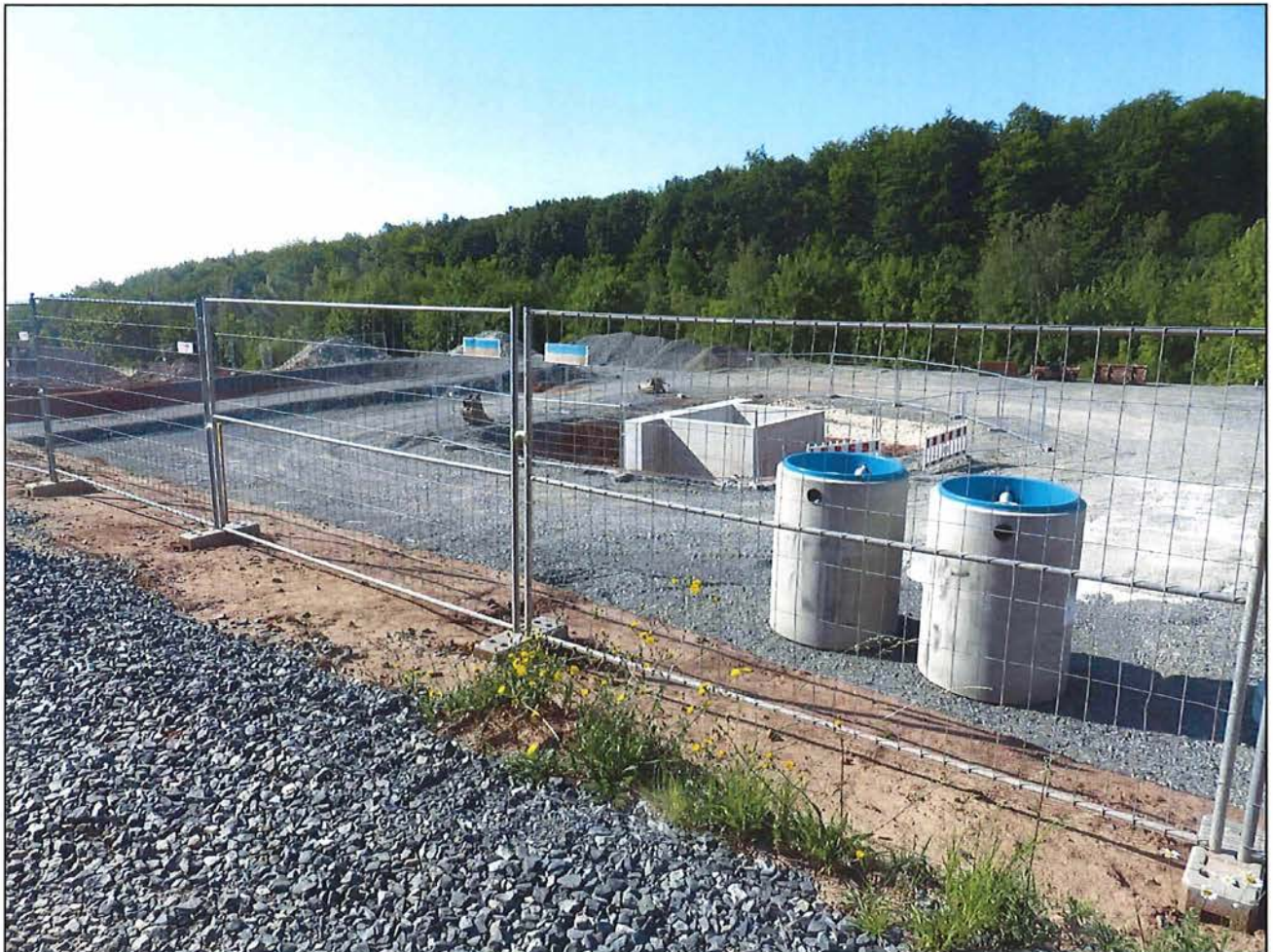
Abbildung 28: Einrichten des Bohrplatzes R10, Aufnahmedatum: 07.08.2020
