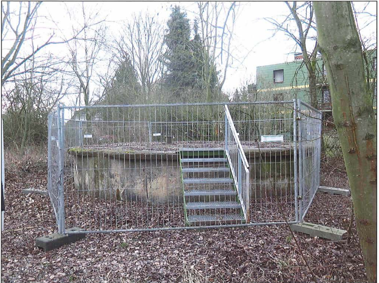
Abbildung 27: Schacht Asse 3 (Aufnahmedatum: 10.03.2017)
