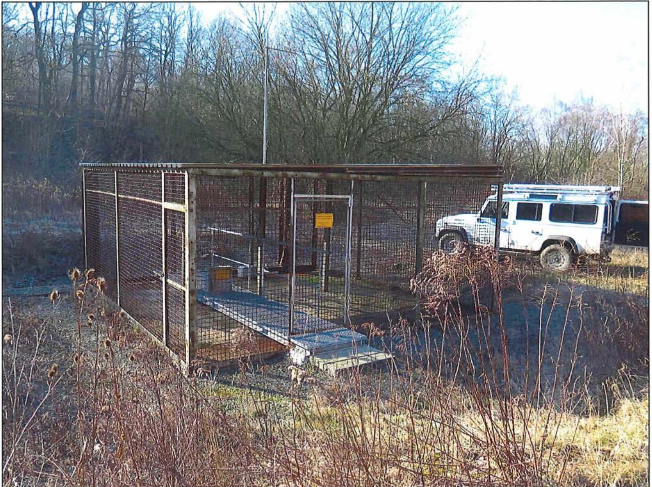
Abbildung 26: Schacht Asse 1 (Aufnahmedatum: 17.02.2016)
