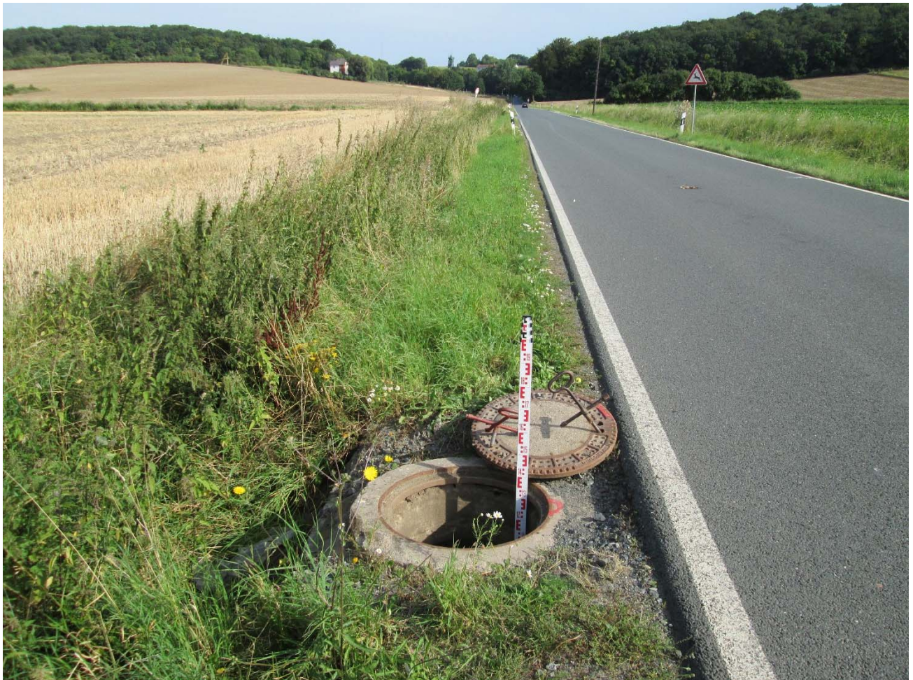
Abbildung 16: Grundwassermessstelle GW-015 (Aufnahmedatum: 20.08.2012)
